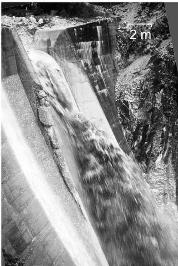
**Figure 1-6:** Passage du corps d'une lave torrentielle sur un barrage (Illgraben)
